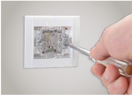
④ Tırnak vidalarını sıkarak duvara sabitleyin.
